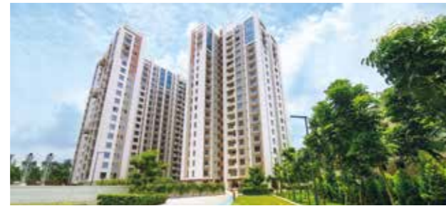
Ozone, South EM Bypass
